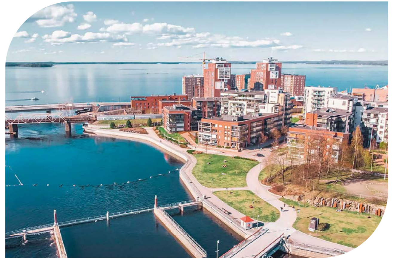
Kuva 32 Kasvava kaupunki rakentaa paljon niin asuntoja, palveluja kuin kaupunki-infraa. Tampere ottaa käyttöön hiilineutraaliskriteerit koko maankäytön prosessissa, laskee rakentamisen hiilijalanjäljen ja minimoi sen mm. puurakentamisella, energiatehokkaalla rakentamisella ja hyödyntämällä mahdollisimman paljon uusiomateriaaleja. Kuva: Visit Tampere Oy / Laura Vanzo.
